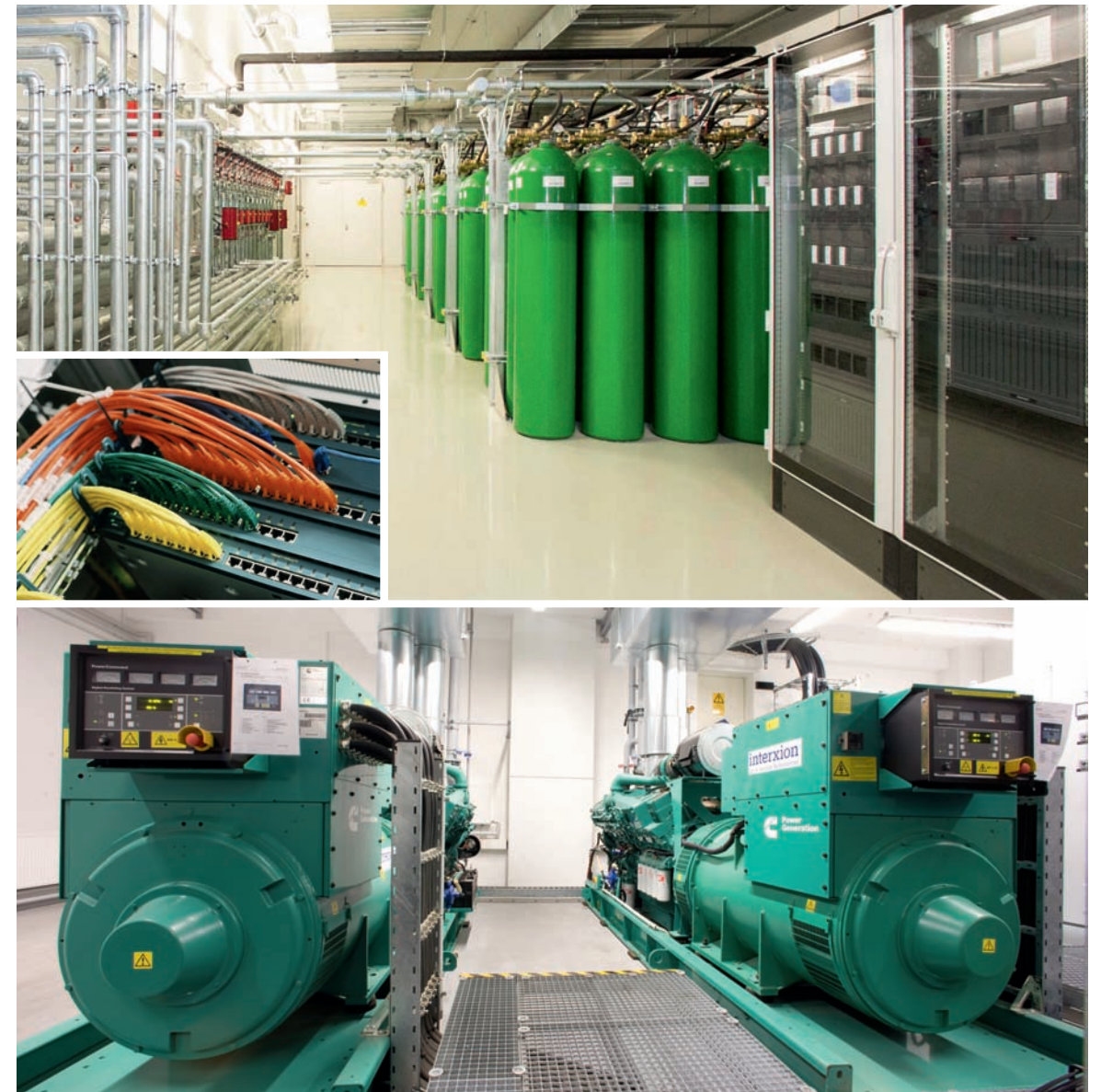
Interxion setzt auf modernste Sicherheitstechnik, z.B. bei Löschgas-Anlagen (oben) und redundanten Notstromsystemen für einen unterbrechungsfreien Dauerbetrieb (unten). Der Campus bietet direkte Verbindungen zu über 450 Carriern und Internet Service Providern (Mitte). Abbildung linke Seite: Der hochmoderne Interxion-Campus in Frankfurt.
